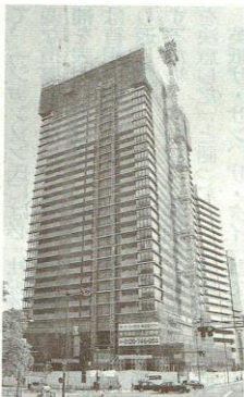
大阪市中心部のマンション建設現場。利便性の高い都心部の物件は価格上昇が続く(大阪北区で)
