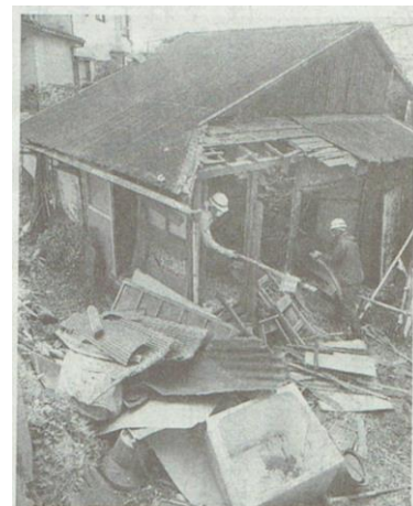
空き家を取り壊すには費用がかかる (神奈川県横須賀市)
