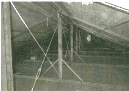
天井裏で部屋を隔てる部材がないアパート（LPオーナー会提供）
